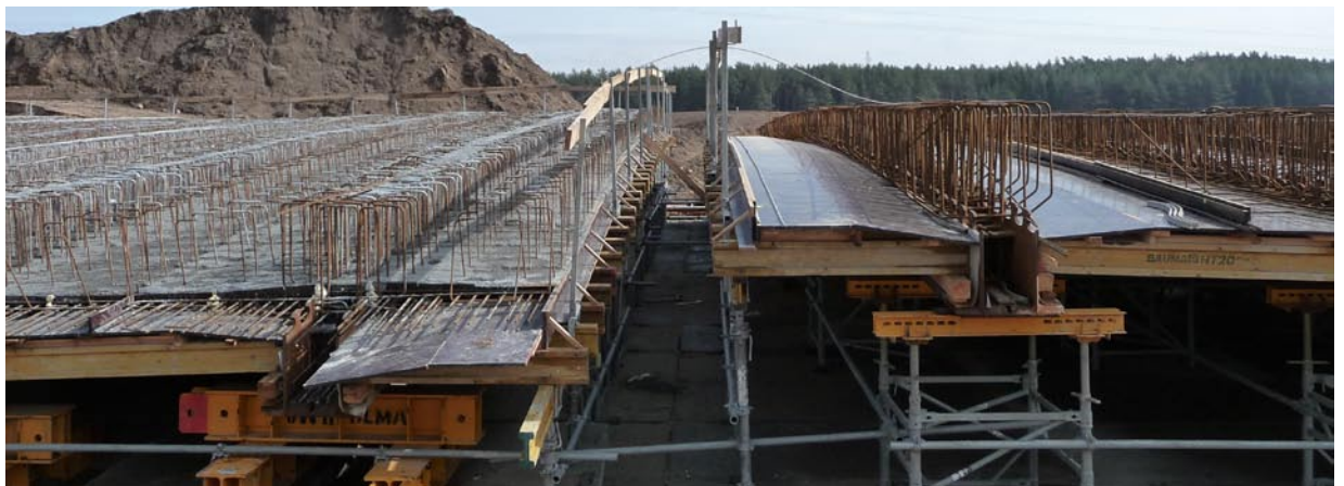
Fot. 5. Podstawowe zbrojenie prefabrykatów prostych (z prawej) oraz zrealizowane już belki zespolone (z lewej)
