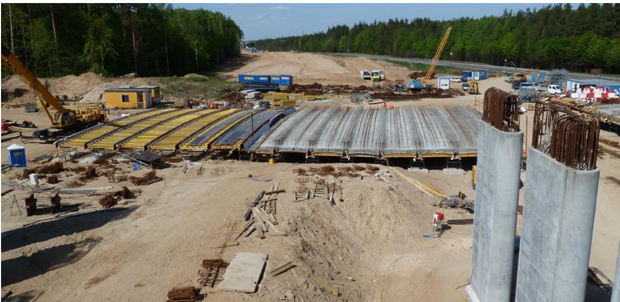
Fot. 2. Widok ogólny stanowiska prefabrykacji belek prostych na placu budowy obiektu PE4
