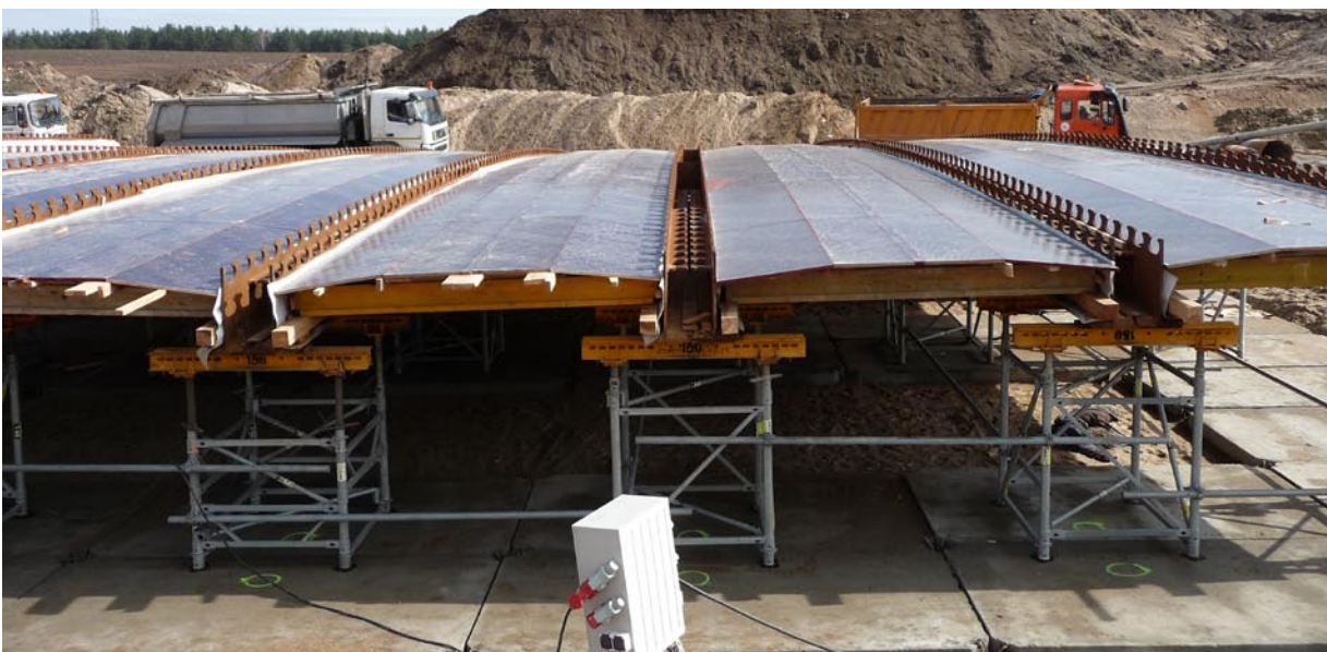
Fot. 3. Deskowanie prefabrykatów belek prostych
