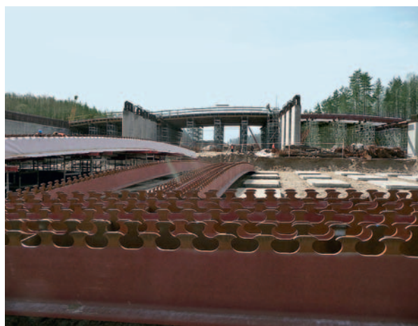
Fot. 1. Obiekt PE4 w trakcie budowy
