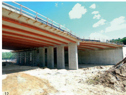
Fot. 9. Belki prefabrykowane drugiej nitki ustawione w pozycji docelowej na podporach tymczasowych
