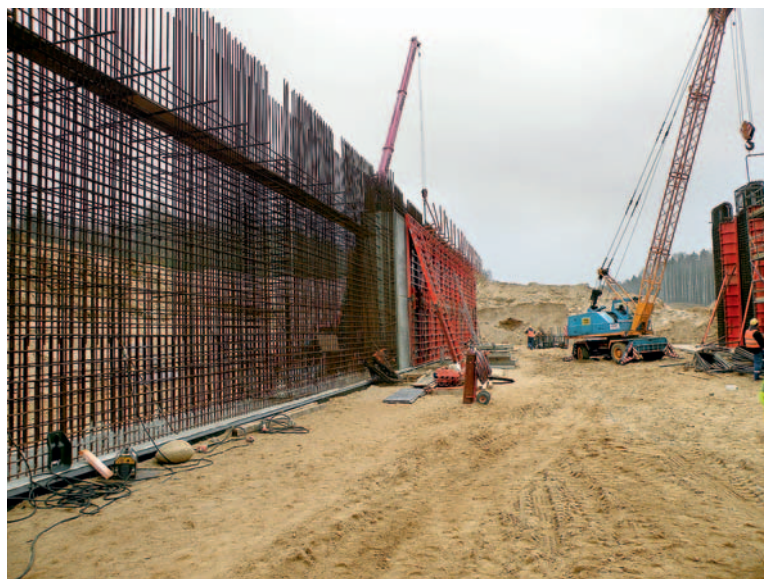
Fot. 3. Przyczółki: zbrojenie i zrealizowana ściana nitki pierwszej
