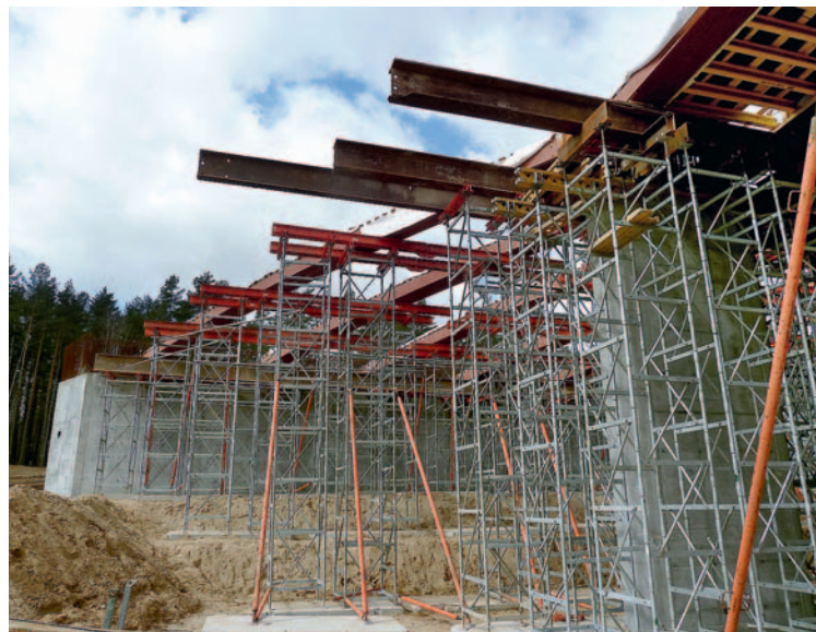
Fot. 4. Belki stalowe przęsla pierwszej nitki oparte na rusztowaniach
