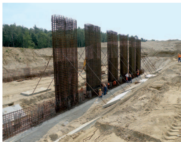
Fot. 2. Oczep palowy i zbrojenie filarów obiektu
