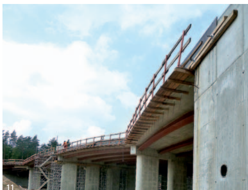
Fot. 9. Belki prefabrykowane drugiej nitki ustawione w pozycji docelowej na podporach tymczasowych
