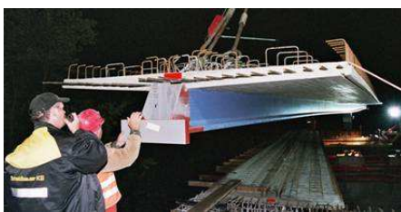
Rys. 2. Obiekt z dźwigarów VFT-WIB (wiadukt w Pöcking): a) dźwigary walcowane po przecięciu i zabezpieczeniu antykrozyjnym w warsztacie, b) zespolenie płyty prefabrykowanej, c) transport dźwigarów na plac budowy, d) montaż dźwigara o długości 32,5m (belka dwuprzęsłowa)
