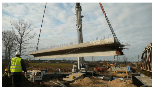
Rys. 7. Prefabrykat zespolony w trakcie montażu na placu budowy (zdjęcie: Intop Tarnobrzeg)
