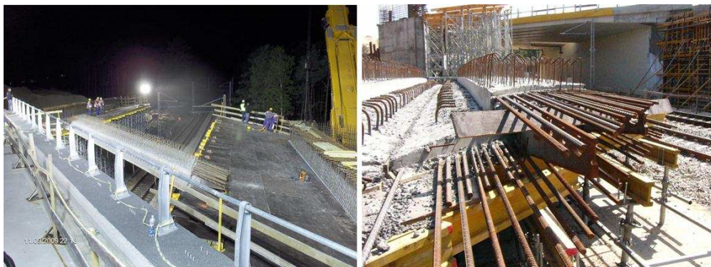
Rys. 10. Realizacja obiektu – prefabrykat ustawiony nad linią kolejową (z lewej) i prefabrykaty na tle dwóch zrealizowanych ram (z prawej); zdjęcia Budimex-Dromex
