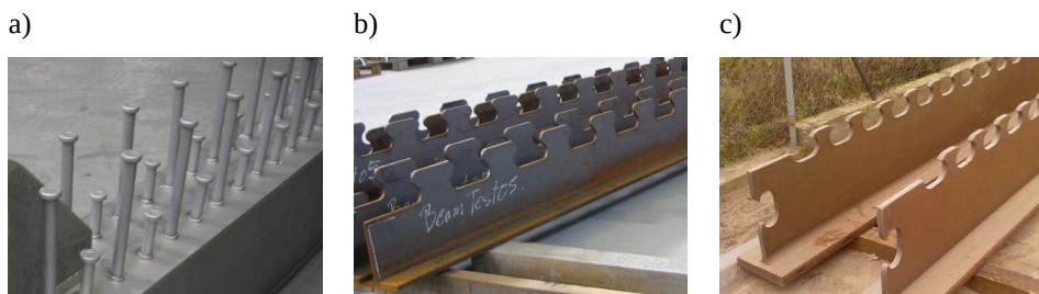
Rys. 3. Stalowe łączniki jako części składowe zespolenia: a) łączniki sworznikowe (klasyka), b) zespolenie „ composite dowels ” kształt PZ, c) zespolenie „ composite dowels ” kształt MCL (zdjęcie: INTOP Szczecin)
