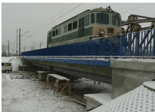
Rys. 8. Most podczas obciążenia próbnego realizowanego przez Instytut Badawczy Dróg i Mostów (zdjęcie: Intop Tarnobrzeg)
