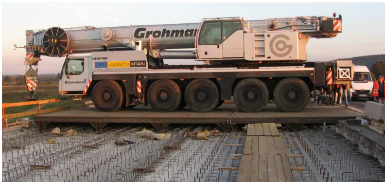
Rys. 10. Dźwig po wjeździe na platformę.
