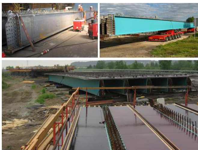
Rys. 3. Etapy realizacji prefabrykatów VFT.
