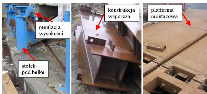
Rys. 6. Dodatkowe elementy montażowe
