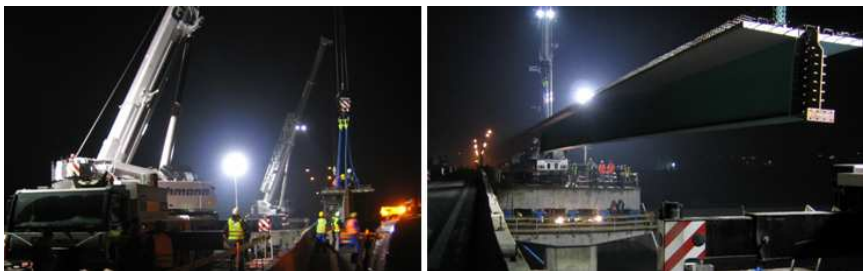
Rys. 11. Montaż prefabrykatów za pomocą dwóch dźwigów o udźwigu 160 ton.
