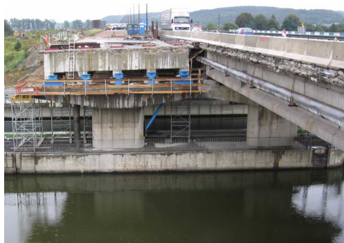
Rys. 1. Widok ogólny konstrukcji obiektu istniejącego w trakcie przebudowy
