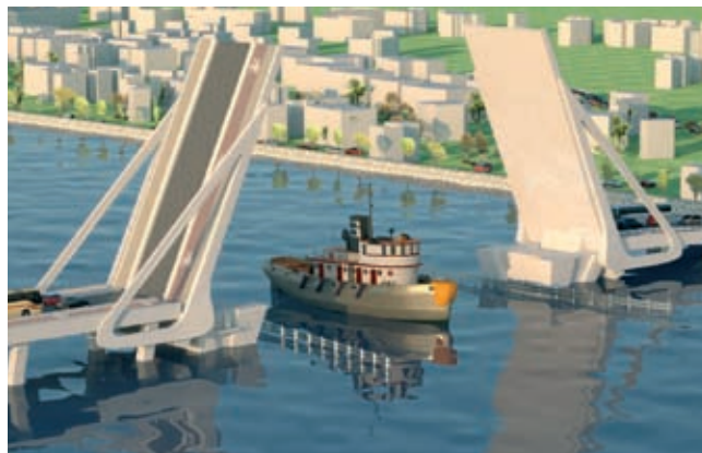
Rys. 10. Most zwodzony, wariant II, widok ogólny, most podniesiony
