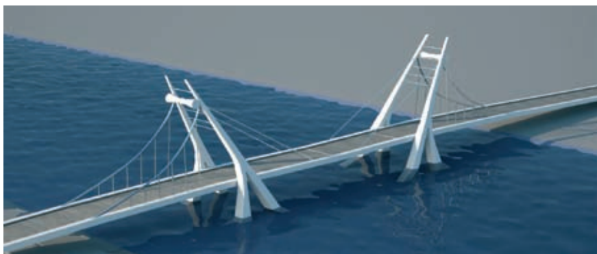
Rys. 4. Most zwodzony, wariant I, widok ogólny, stan opuszczony
