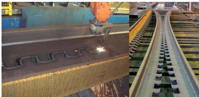
Ryc. 10. Wiadukt drogowy w Vigaun – cięcie dźwigarów stalowych
