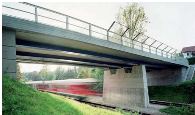
Ryc. 7. Wiadukt drogowy w Pöcking – widok ogólny obiektu
