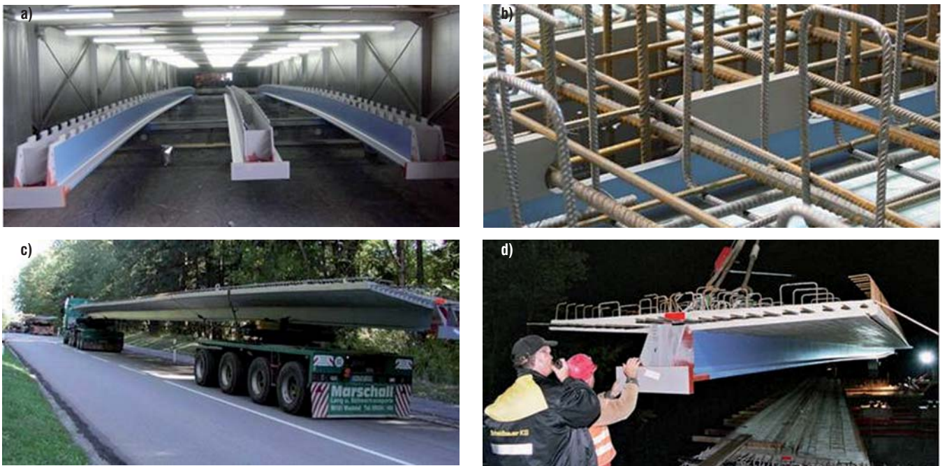
Ryc. 3. Technologia budowy obiektu z dźwigarów VFT-VIB® (wiadukt w Pöcking): a) dźwigary walcowane po przecięciu i zabezpieczeniu antykorozyjnym w warsztacie, b) zespolecie composite dowels płyty prefabrykowanej, c) transport dźwigarów na plac budowy, d) montaż dźwigara o długości 32,5 m (prefabrykat pod dwa przęsta)
