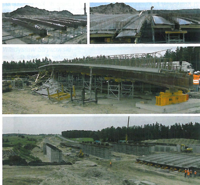
Rys. 7. Budowa przejścia ekologicznego PE1 z belek VFT-WIB
