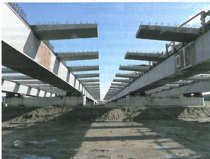
Rys. 10. Konstrukcja obu nitek estakady ED1A po nasunięciu podłużnym na podpory
