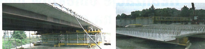
Rys. 4. Budowa mostu drogowego z belek VFT-WIB
