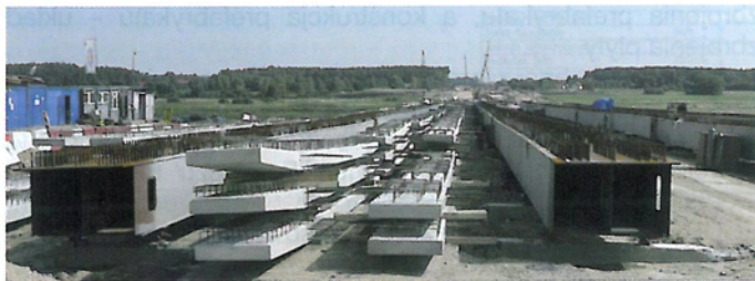
Rys. 9. Konstrukcja stalowych skrzynek i prefabrykowanych poprzecznic estakady ED1A przed nasunięciem na podpory
