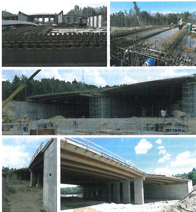
Rys. 6. Budowa przejścia ekologicznego PE4 z belek VFT-WIB
