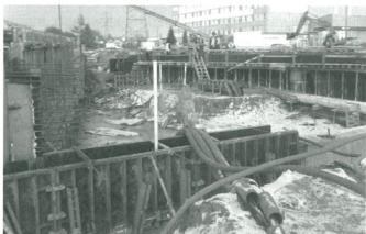
Fot. 5. Wykonywany strop segmentu 56
