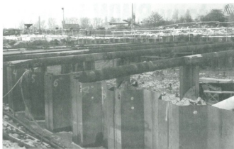
Fot. 6. Segmenty 1–8 rozparte stalowymi rurami
