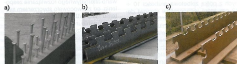
Rys. 3. Stalowe łączniki jako części składowe zespolenia: a) łączniki sworzniowe (rozwiązanie klasyczne), b) zespolenie composite dowels kształt PZ, c) zespolenie composite dowels kształt MCL (fot. INTOP Szczecin)
