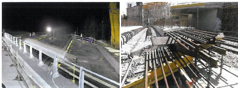
Rys. 7. Realizacja obiektu – prefabrykat ustawiony nad linią kolejową (z lewej) i prefabrykaty na tle dwóch zrealizowanych ram (z prawej); fot. Budimex-Dromex
