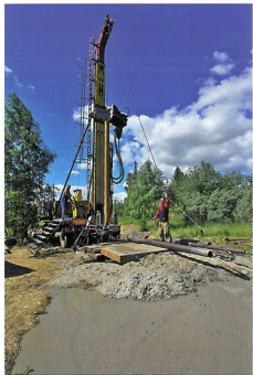
Fot. 2. | Wielotracznica w trakcie realizacji otworu badawczego
