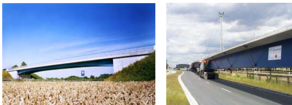
Rys. 2. Wiadukt ramowy VFT nad autostradą i transport dźwigarów prefabrykowanych
