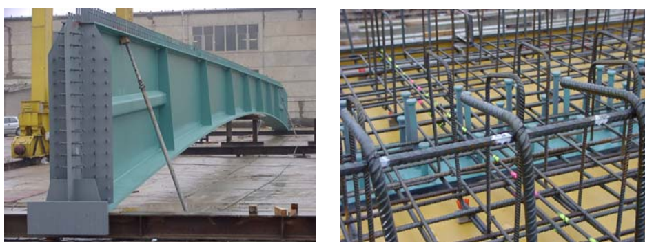
Rys. 3. Dźwigar stalowy w wytwórni i sworznie oraz zbrojenie półki prefabrykatu
