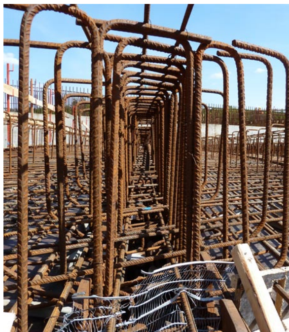
Fot. 7. Zbrojenie prefabrykatu przęsła wachlarzowego (ze skośnym układem prętów w planie)
