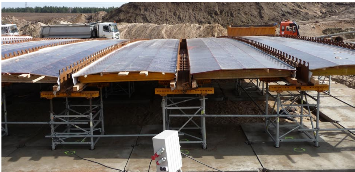
Fot. 3. Deskowanie prefabrykatów belek prostych
